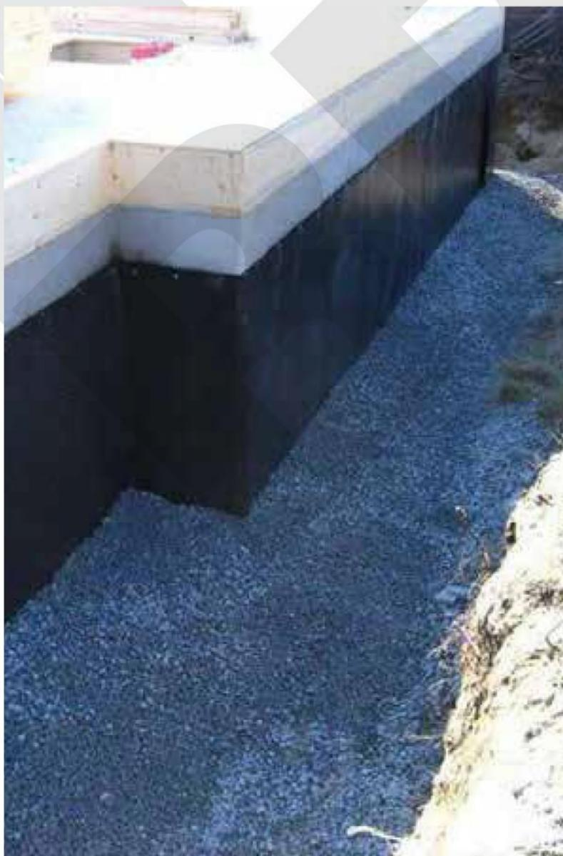
سطوح پوشش داده نشده بتنی با اعمال Master Coat 411 مانع از جذب آب شور می شوند. در حالیکه سطوح بدون پوشش نمک های موجود در زمین مرطوب را جذب نموده و باعث زنگ زدگی فولاد یا فساد بتن می گردند.
